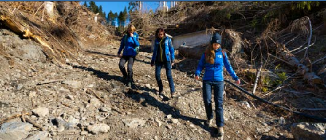
Cantiere Rio Moscardo, Paluzza (Ud)
