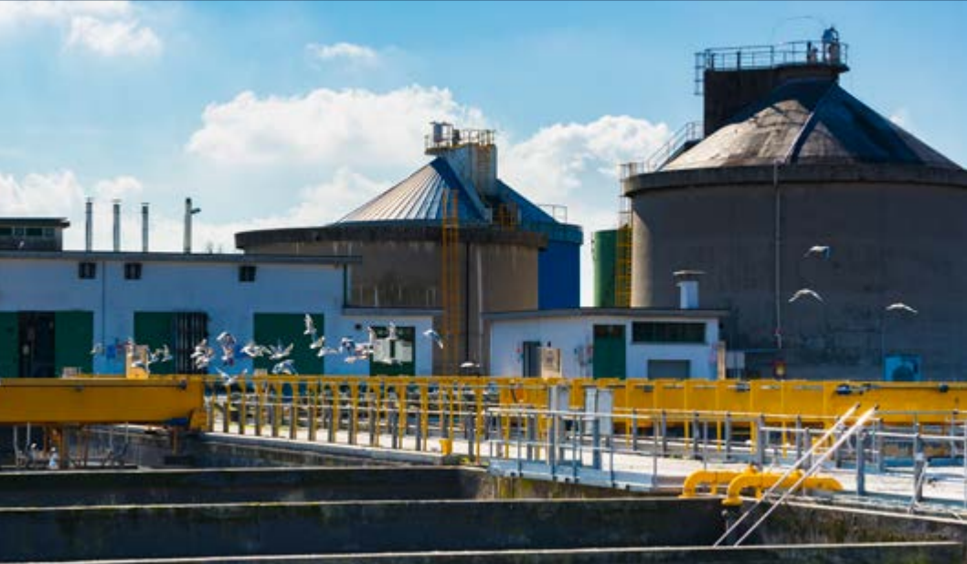
Gasometri Depuratore, Udine
