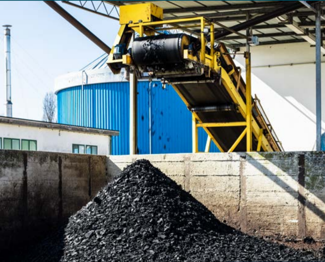
Trattamento fanghi Depuratore Udine
