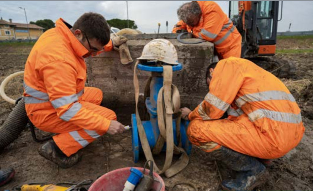
Sostituzione valvola Aprilia Marittima, Latisana (Ud)
