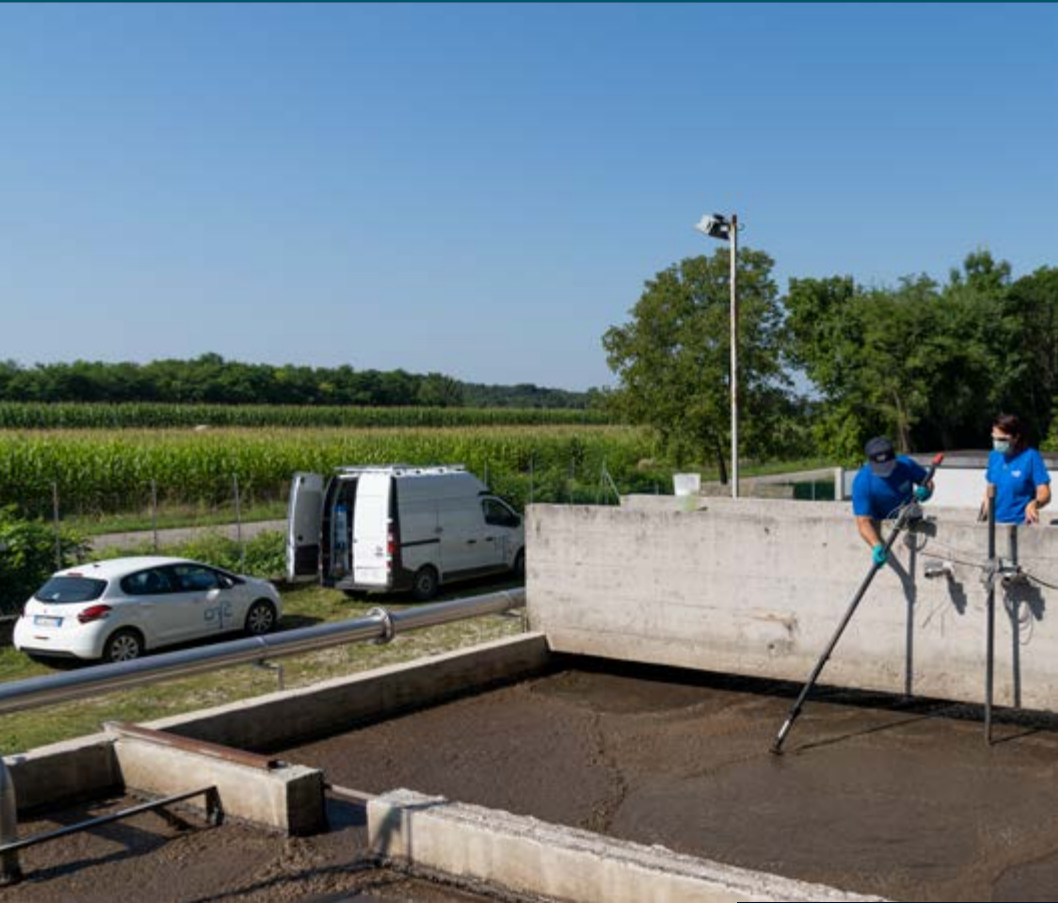
Pulizia sonde depuratore Cassacco (Ud)
