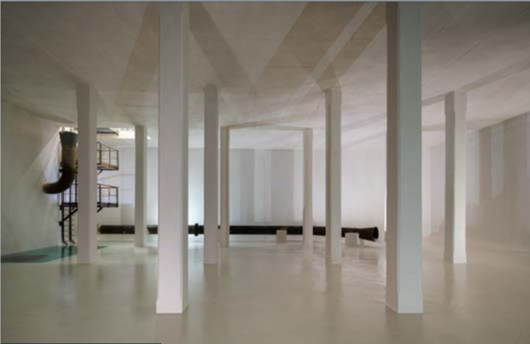
Resinatura serbatoio Rive d'Arcano (Ud)
