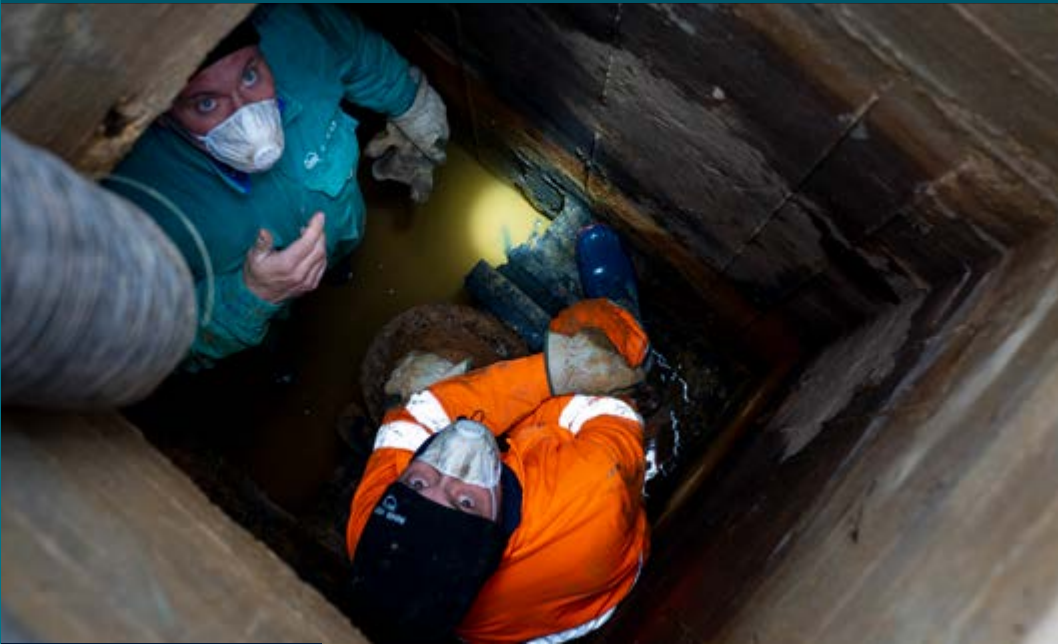
Sostituzione valvola Aprilia Marittima, Latisana (Ud)
