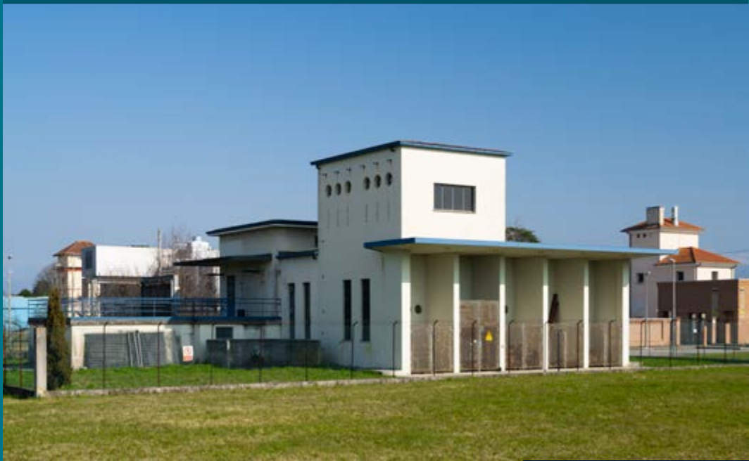
Centrale idroelettrica Ancona Udine
